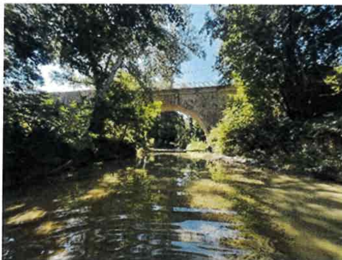
Figure 3 : le maintien des sections hydrauliques est une prescription systématique au droit des ouvrages de franchissement
