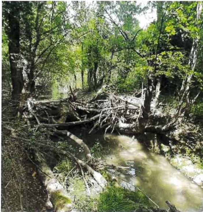
Figure 1 : Cet embâcle situé en zone naturelle contribue à la qualité du milieu. Pour autant, par ses dimensions il entrave complètement la continuité piscicole et sa reprise en crue est peu probable. Pour ces raisons il mérite d'être démonté. Le bois mort sera néanmoins laissé sur place pour les qualités biologiques qu'il apporte (torrent de Barlière, Lurs) ;
